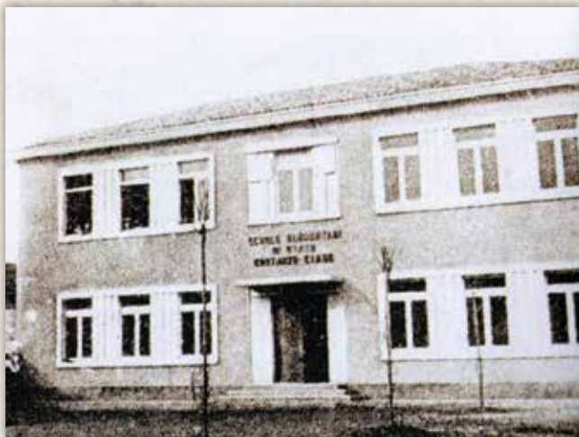
Le prime Scuole Elementari fine anni '30, oggi edificio che ospita le Medie.
